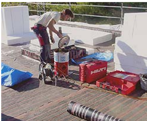
Dachsanierung und -dämmung (Großbild: Dachsanierung und -dämmung; Dachranddetail)
