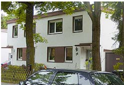
Die Doppelhaushälften vor Sanierung, Straßenseite (Großbild)
